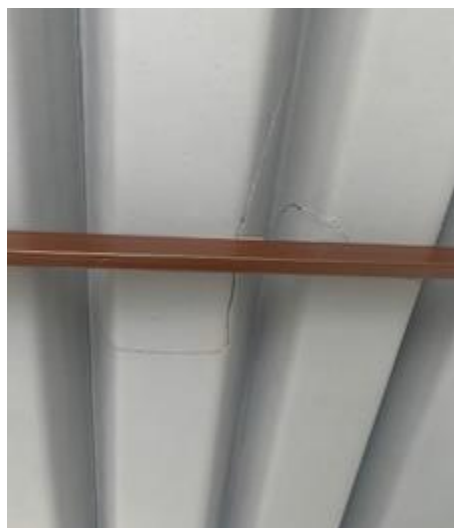
Ilustración 124 Humedad de muros
