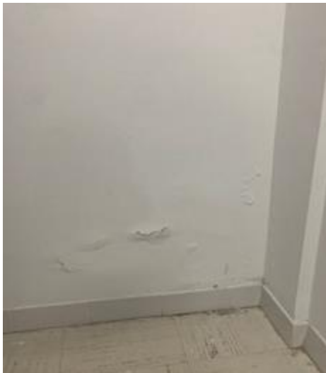
Ilustración 123 Grieta cubierta
