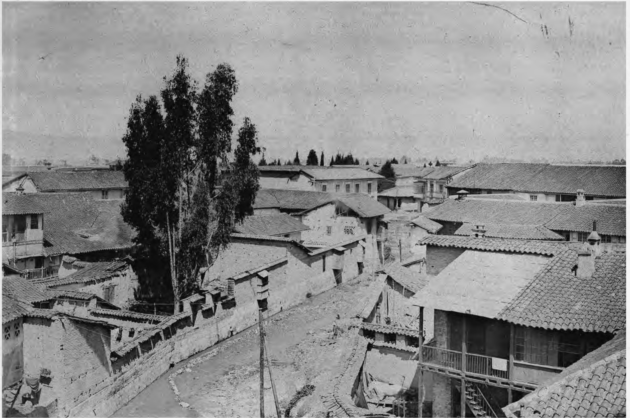
Blick von der Rückseite unserer Wohnung auf den Fluss
