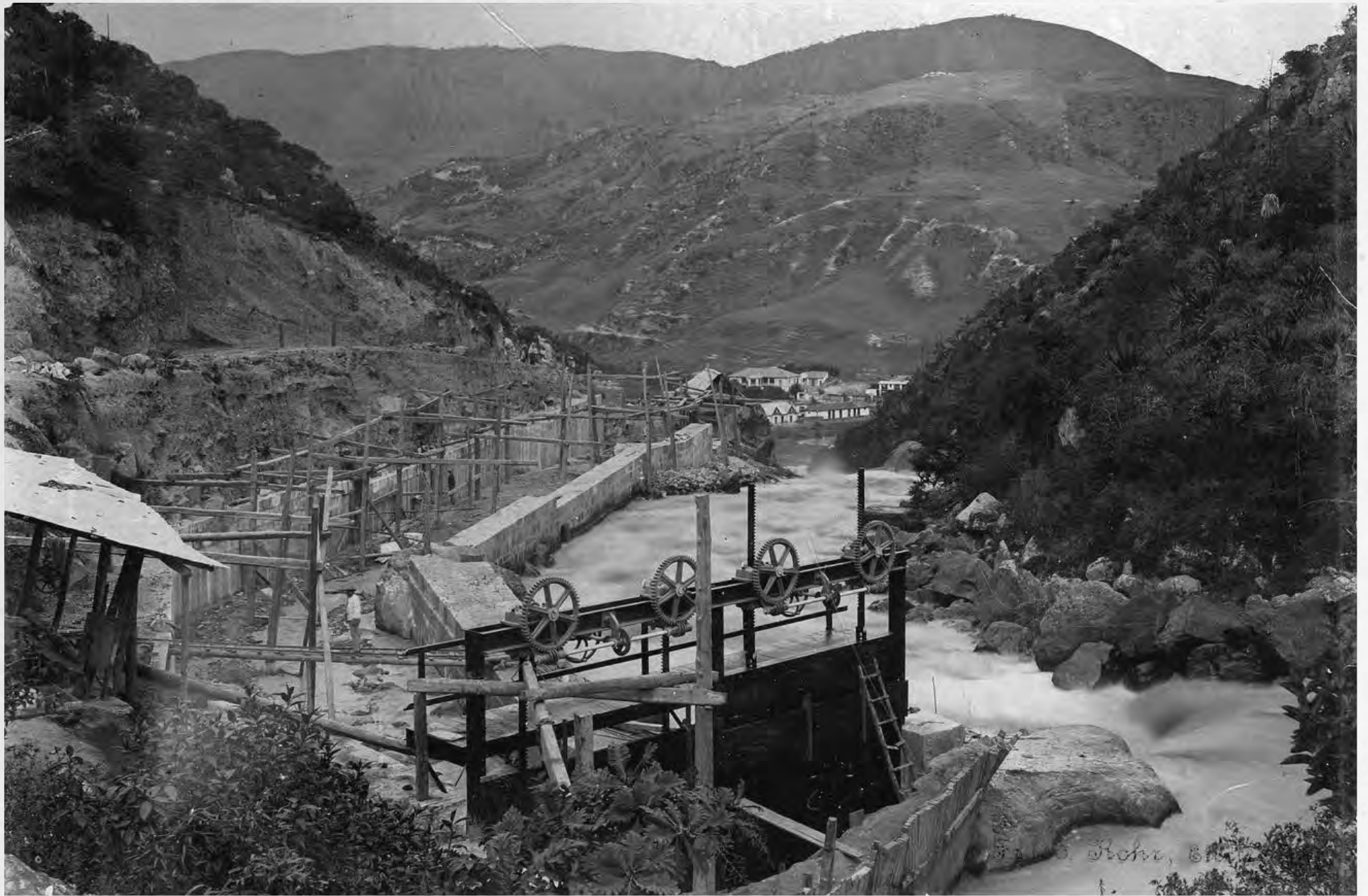
Generalansicht der Kraftanlage bei Chaquito
