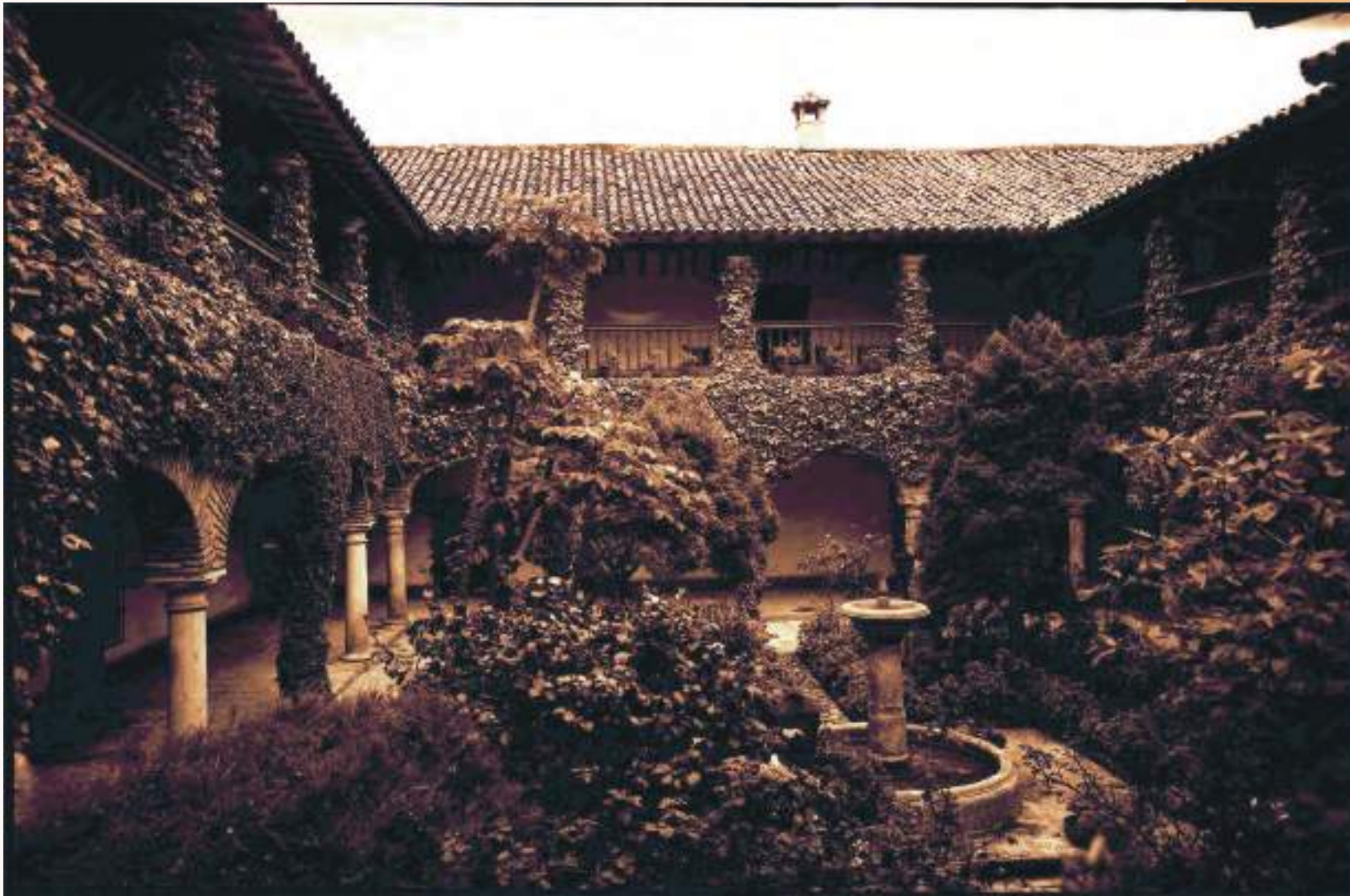
VISTA INTERIOR DE UNA CASA COLONIAL, S.F..
