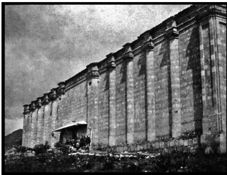
Figura 8. Fachada del Panóptico de Bogotá, 1895
