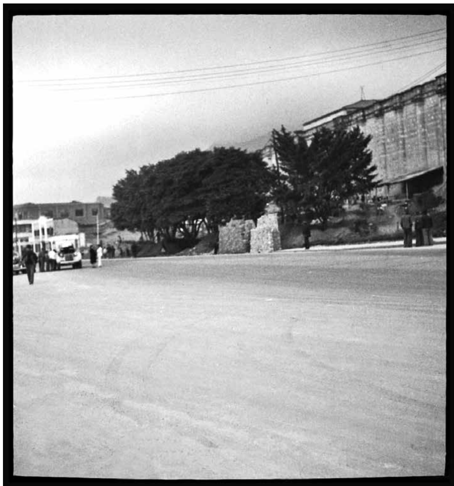
Figura 10. Edificio del Panóptico de Bogotá, actual Museo Nacional de Colombia. Se aprecian las adecuaciones del espacio público en la ampliación de la carrera 7 hacia el norte.
