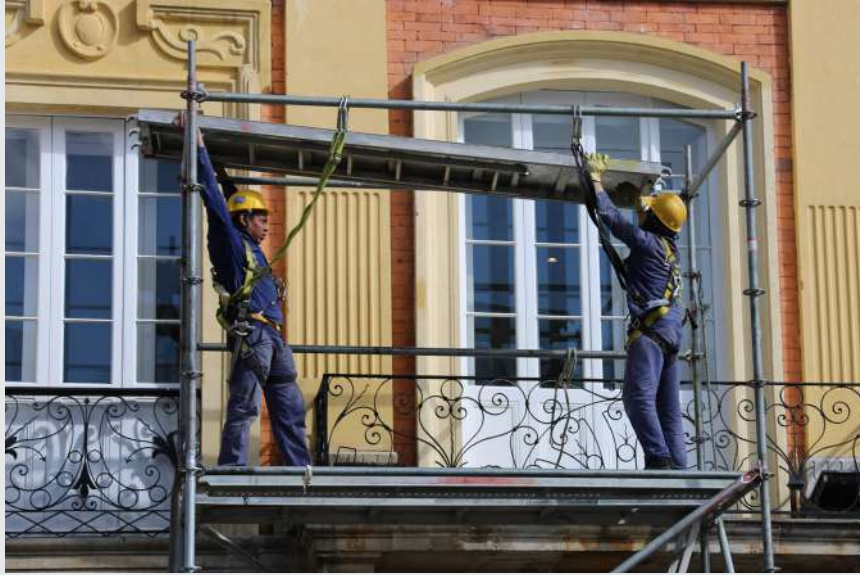
Intervención fachada Palacio Liévano
