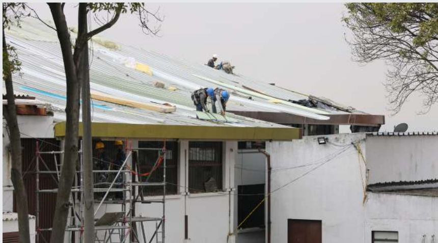
Intervención estructural a la Imprenta Distrital
