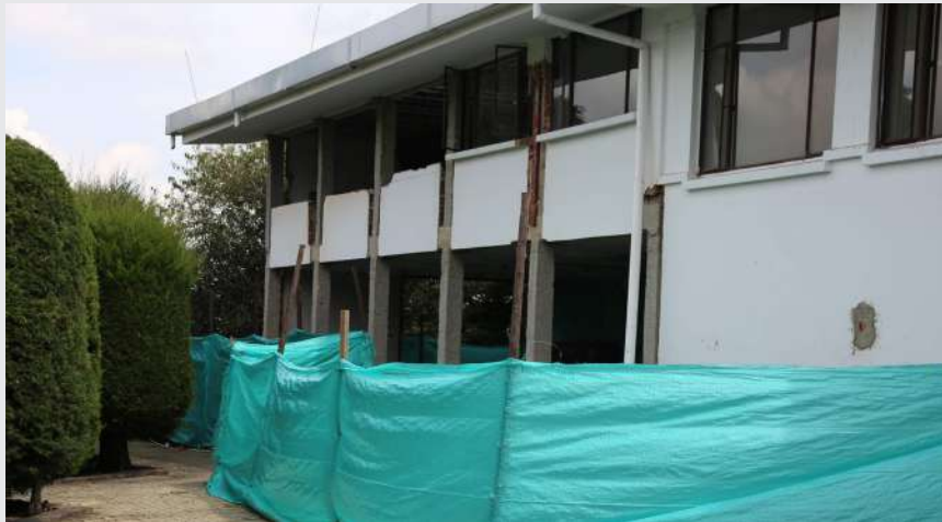
Intervención estructural a la Imprenta Distrital
