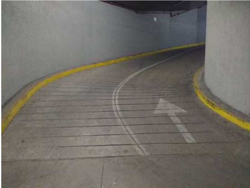
Imagen N°8: Demarcación y delimitación de zonas de tránsito vehicular
