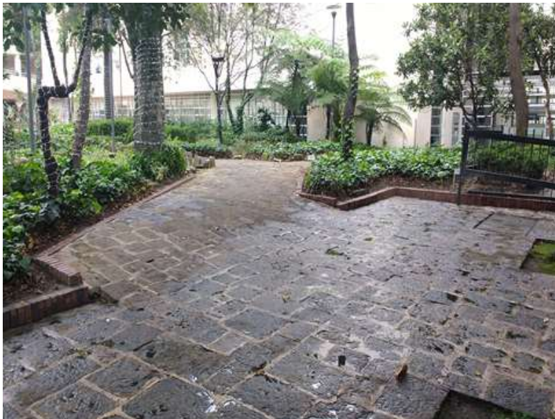
Imagen N°4: Zonas de tránsito peatonal
