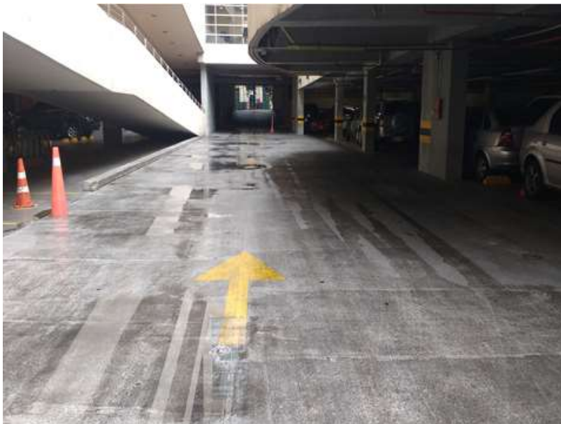
Imagen N°9: Demarcación y delimitación de zonas de tránsito vehicular
