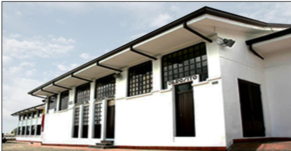
Ilustración 5 SEDE IMPRENTA DISTRITAL
