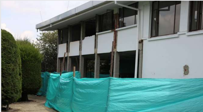
Intervención estructural a la Imprenta Distrital
