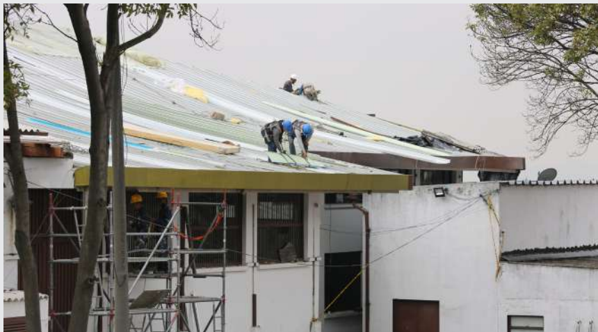
Intervención estructural a la Imprenta Distrital
