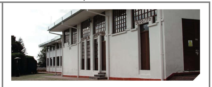
Localidad San Cristóbal: La María. Calle 11 Sur No. 1-60 Este
